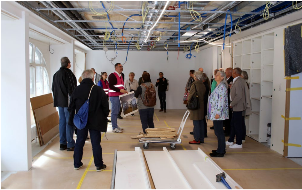
Das Gemeinschaftsbüro sieht noch nach Baustelle aus.
